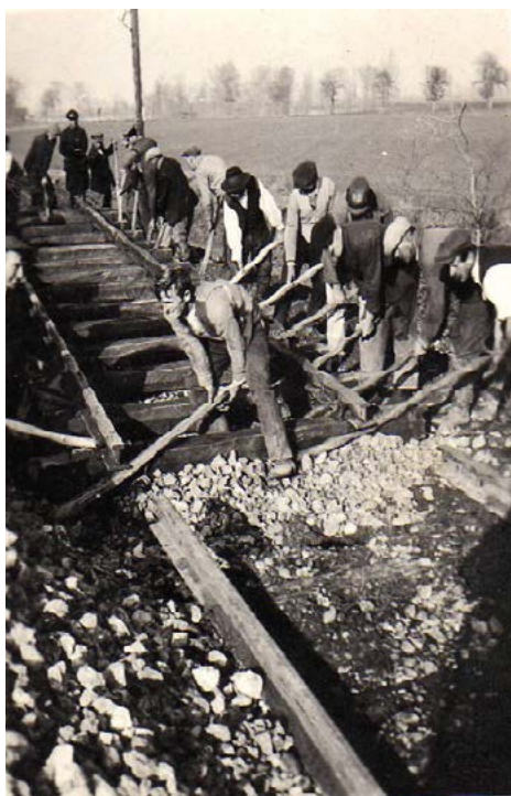
Úprava železničnej stanice Miloslavov v roku 1960, keď sa odstraňovala vedľajšia staničná koľaj. Práce riadil Ľudovít Vyslúžil, ktorý aj so svojou manželkou Alžbetou slúžili na našej železničnej stanici vyše 25 rokov
