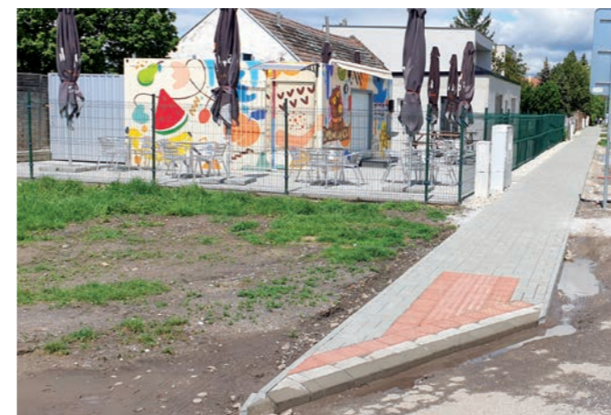
Chodník Lesná ul. – 1.etapa
