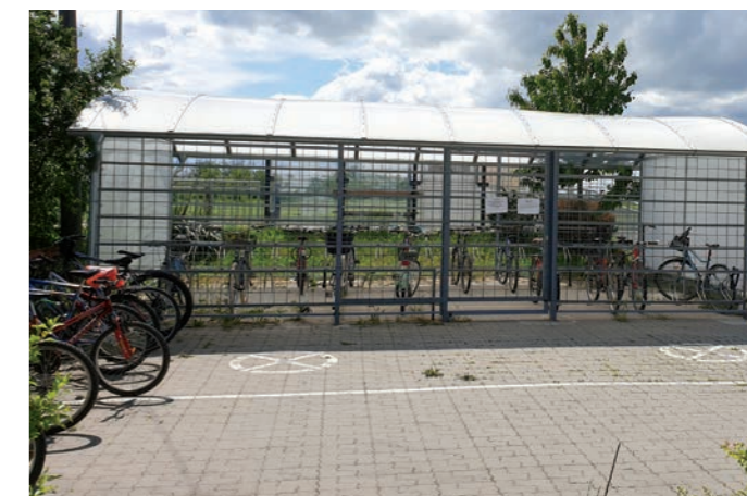
Prístrešok pre bicykle na železničnej stanici
