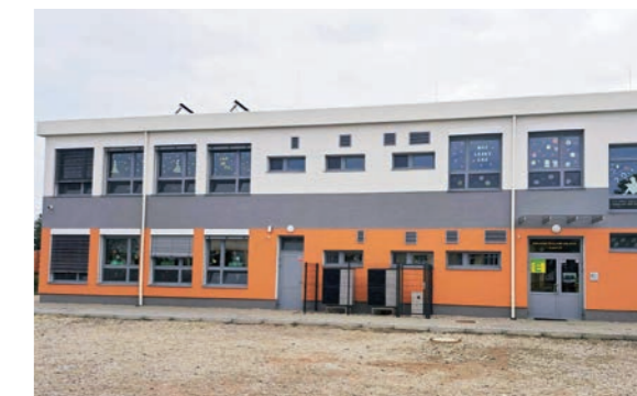
Nová budova pre 1. stupeň Základnej školy
